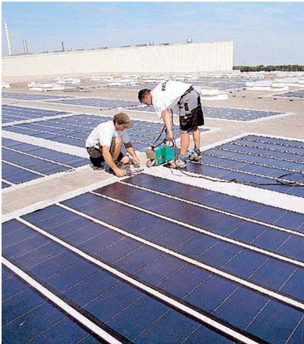
ALL'OPERA In questi giorni si lavora per installare i pannelli
